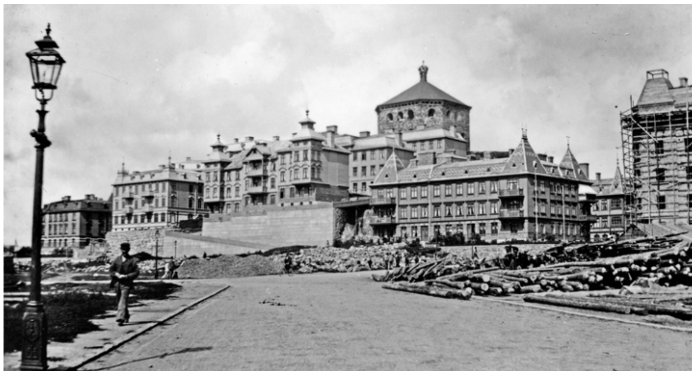
Unik bild från ca 1910 före byggnationen av Kastellgatan och Majorsgatan. På berget syns de vackra landshövdingehusen som revs på 1960-talet. Till höger sådana träpålar som hela Kommendantsängens byggnader vilar på.
